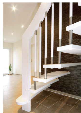
Das weiß gewachste Holz der Buche wirkt in Kombination mit den Elementen aus Edelstahl modern und zeitgemäß. Handlauf und Pfosten sind schlicht gehalten. (Foto: epr/STREGER) 057 02
