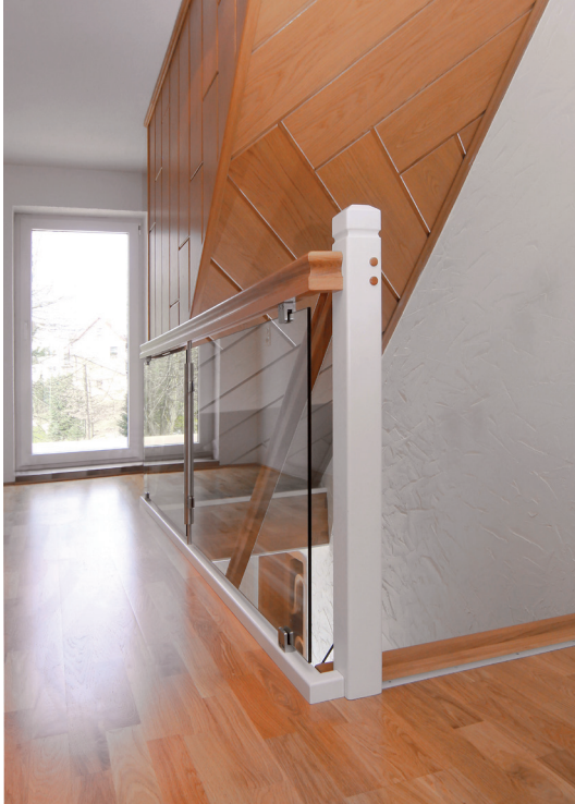
Verbund-Sicherheitsglas überzeugt durch seine zahlreichen Sicherheitseigenschaften, die es einer reißfesten, elastischen Folie zwischen den Glasscheiben verdankt. Selbst im Falle eines Bruches ist das Verletzungsrisiko minimal. (Foto: STREGER)
