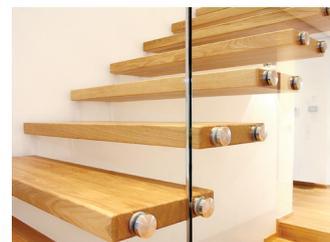
*Gummigelagerte Edelstahlbolzen dämmen zum einen den Tritt beim Hinauf- und Hinabgehen der Treppe und versprühen zum anderen Eleganz und Modernität.
