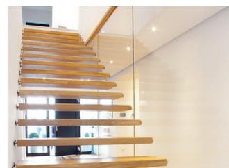
*Als Absturzschutz wurde vom Boden bis zur Decke Verbundsicherheitsglas eingesetzt. Es bietet Sicherheit und bringt Leichtigkeit in die Konstruktion.
